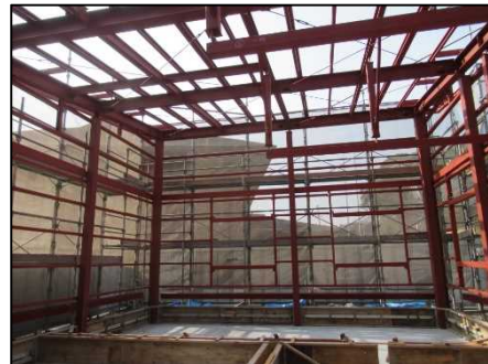
鉄骨建方状況
