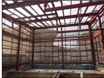
鉄骨建方状況
