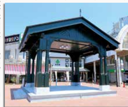
復原された二代目直方駅舎車寄せ (駅前公園)
