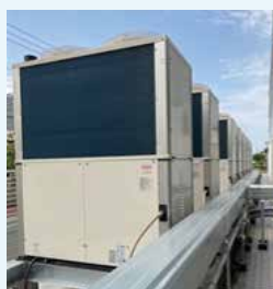
発電機能付ガス空調システム (室外機)
