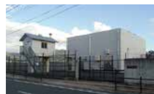
北小川排水ポンプ場
