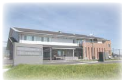
直方市汚泥再生処理センター グリーンHitzのおがた
