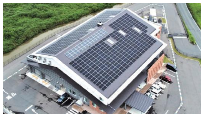
▲汚泥再生処理センターに設置された太陽光パネル
