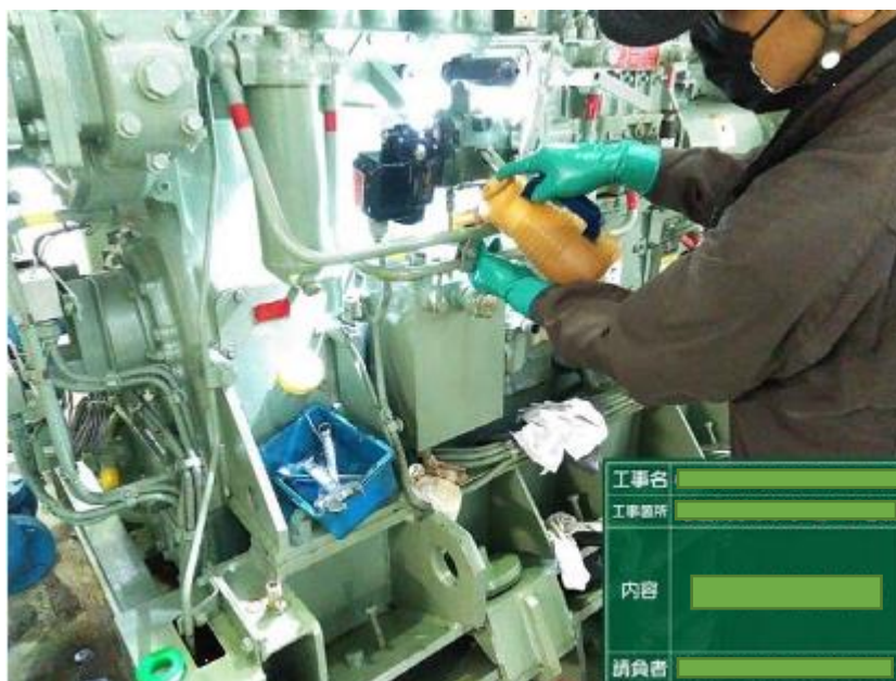
図 7.4.9 雨水ポンプ施設点検整備
