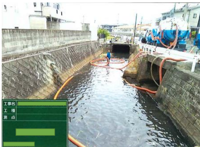
図 7.4.10 重点管路清掃状況
