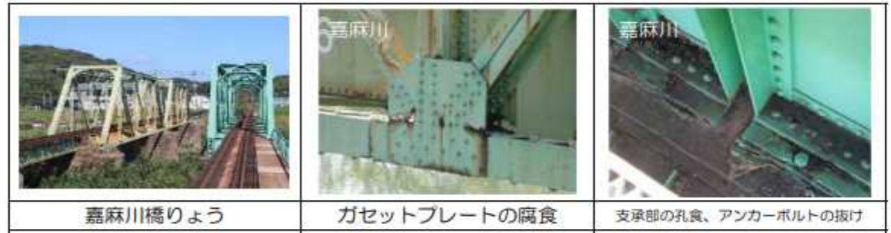
※竣工（明治35年）後120年経過している嘉麻川橋りょう
