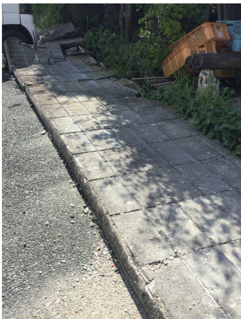
地震によりブロック塀が倒壊
