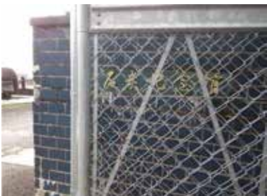
⑦ 門柱（正門側）
