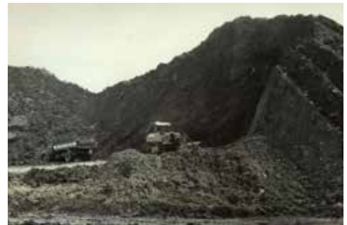
図 2-3-7 ボタ山を崩す様子
