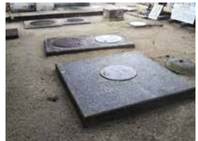
⑰ 合併浄化槽
