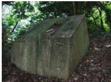
③5 伊田坑竖坑跡の基礎
