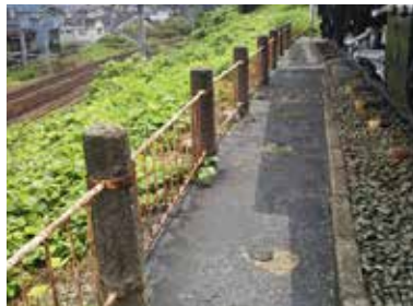
⑤ -1 コンクリート柱（明治43年）
