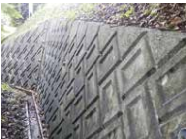
⑳ -2 コンクリート擁壁
