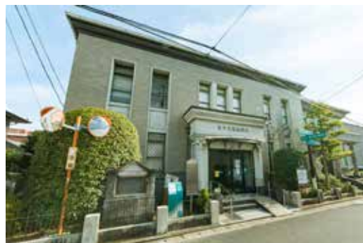
図 2-4-12 旧奥野医院（直方谷尾美術館 洋館）
