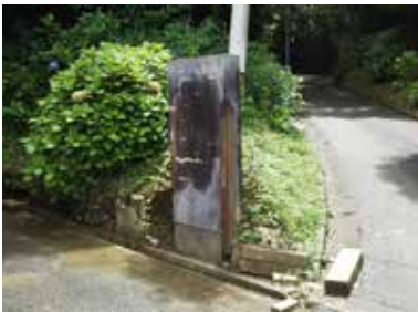
⑫ 門柱（自動車進入路側）
