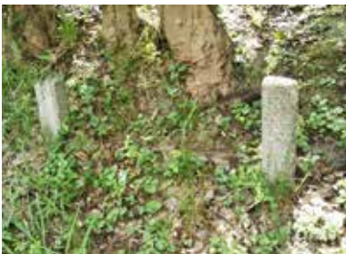
⑤ -3 コンクリート柱（明治43年）
